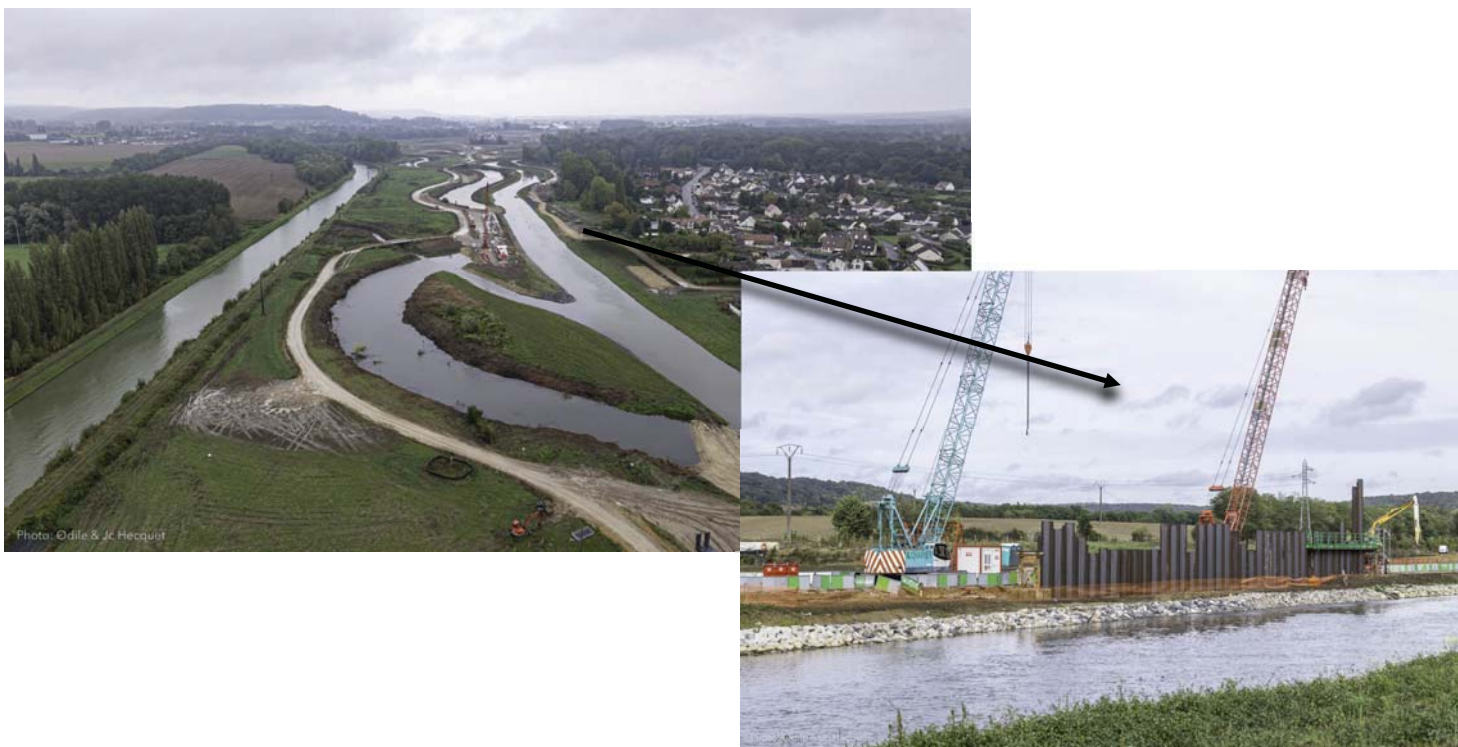
Réalisation du rescindement de l'Oise à Montmacq et du déversoir de crue
